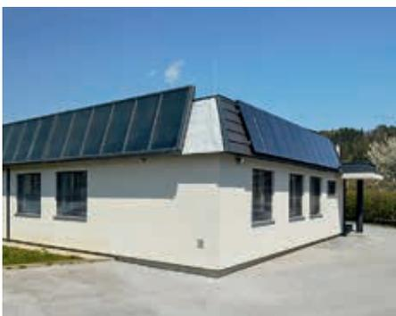
Auf dem LSI-Haus wird die Sonne gleich zweifach eingefangen – einmal mit Photovoltaikmodulen zur Stromgewinnung und einmal mit einer Solaranlage zum Heizen.
